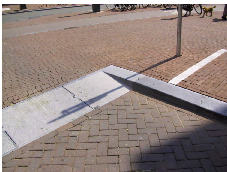
Voorbeeld gebakken bestrating en natuursteen banden
