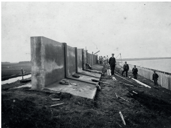
De aanleg van Muraltmuurtjes in Scharendijke, 1907-1908.
