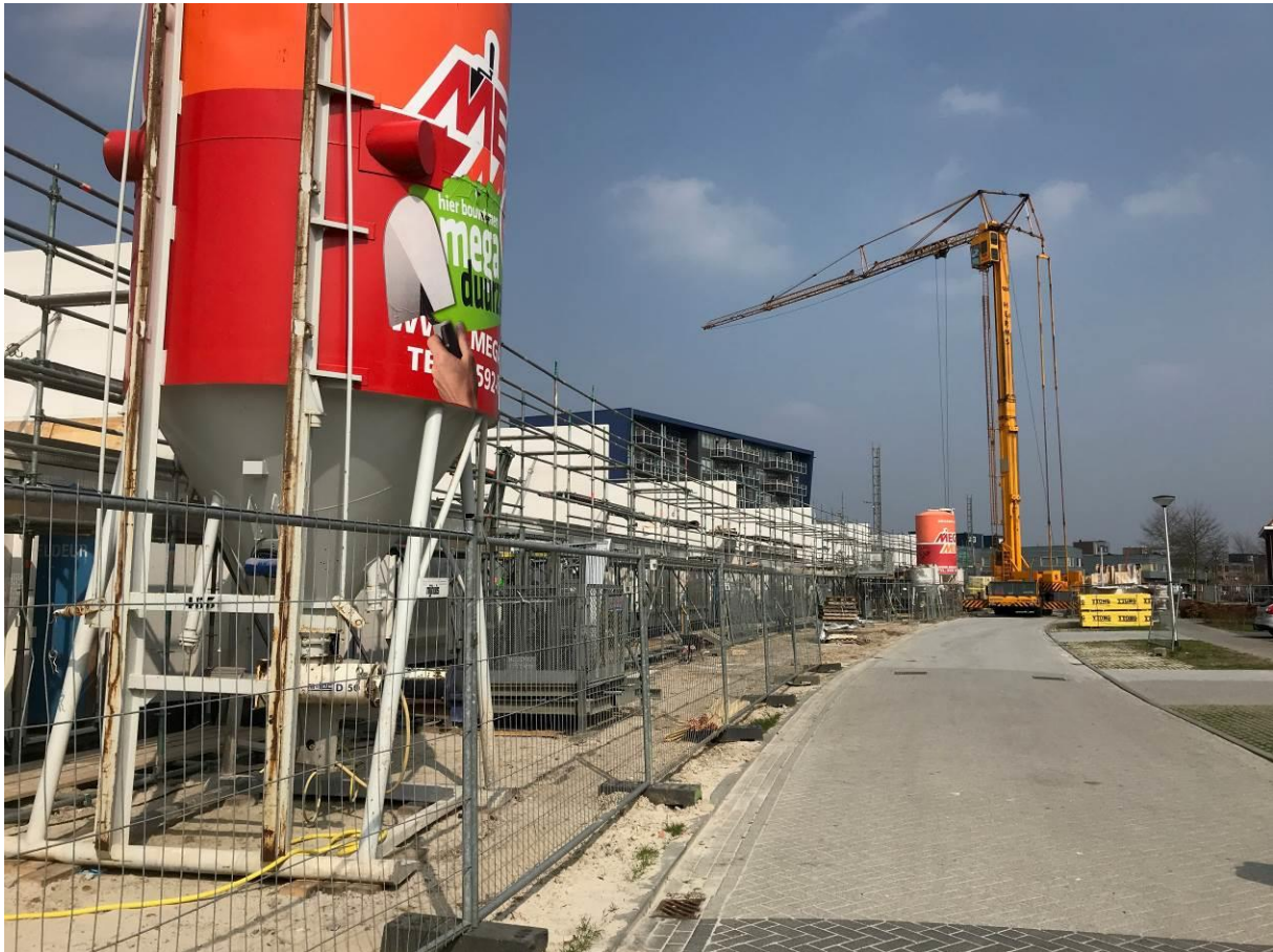
Nieuwbouw project 'Nieuw Assen' - Assen Oost
