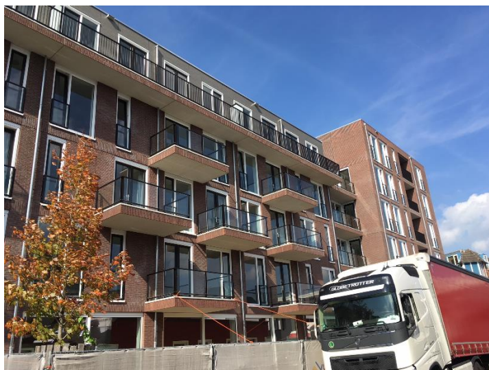
Opgeleverd: 77 huurappartementen Arendstate – Groningerstraat (foto Accolade Zorggroep)
