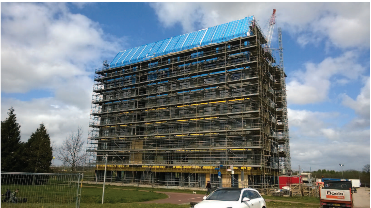
Messchenstaete in aanbouw, april 2016
