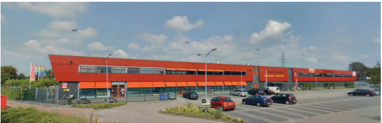
Bebouwing langs Peelo: Messchenstaete (linksboven), het kantoor van Aprisco (rechtsboven) en het clubgebouw van Achilles 1894
