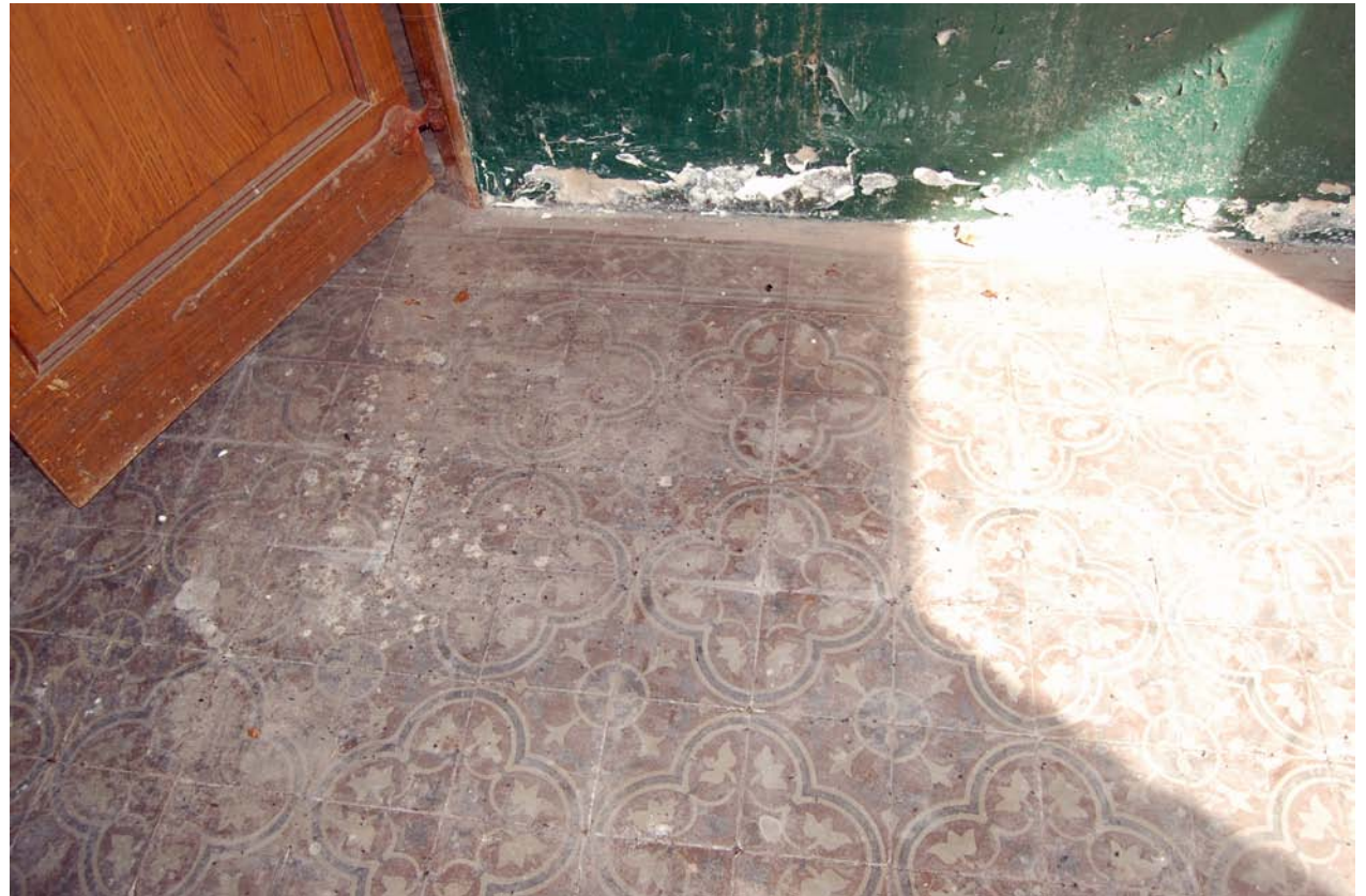
Vloer van de caféruimte, uitgevoerd in gekleurde cementtegels met een geometrisch patroon.
