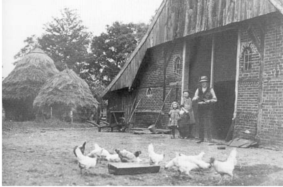
Achtergevel van een oude boerderij met een traditioneel ingericht erf. De achtergevel is nog uitgevoerd in vakwerk dat met metselwerk gevuld is. De topgevel heeft verticaal beschoot.
