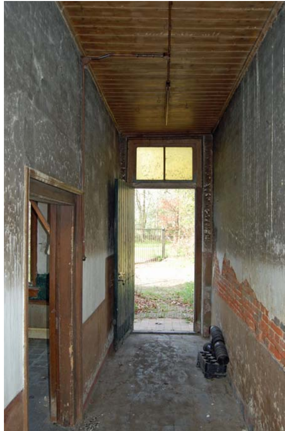
Overzicht van de gang met links de deur naar de heerd.
