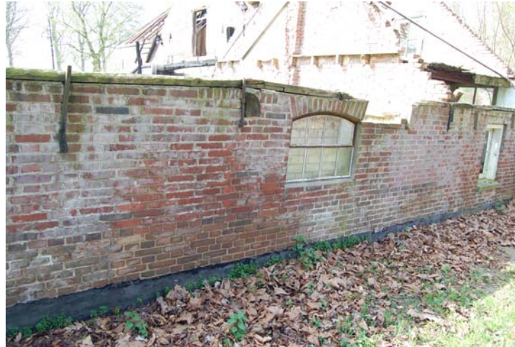
Linker zijgevel van de in 1922 gebouwde (vaalt)stal.
