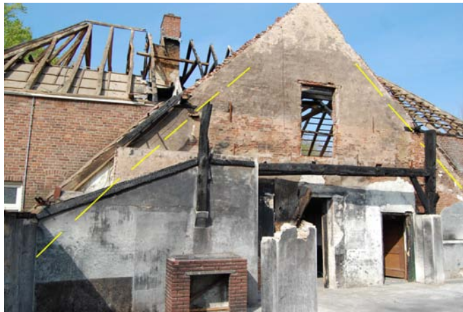
Brandmuur met daarop met een gele lijn het oorspronkelijke verloop van de daklijn ingetekend.
