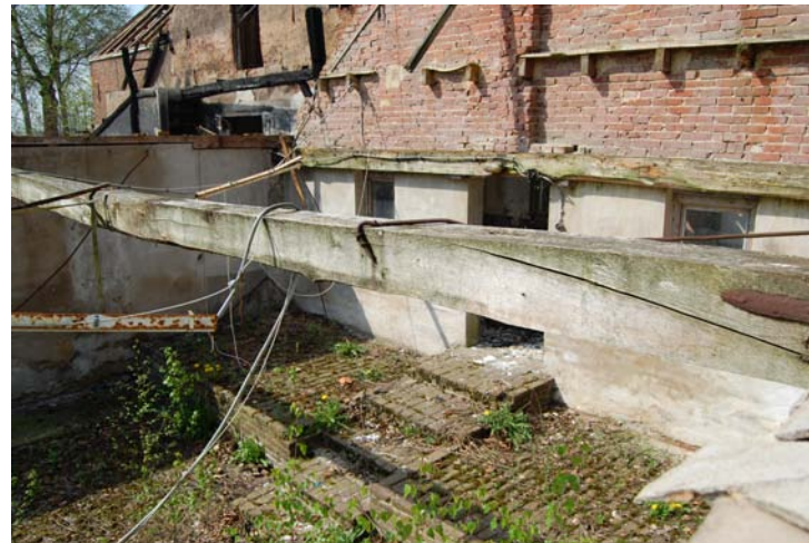
Interieur van de (vaalt)stal met een verdiept aangelegde klinkervloer.
