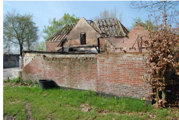
Achterzijde van de aangebouwde stal.
