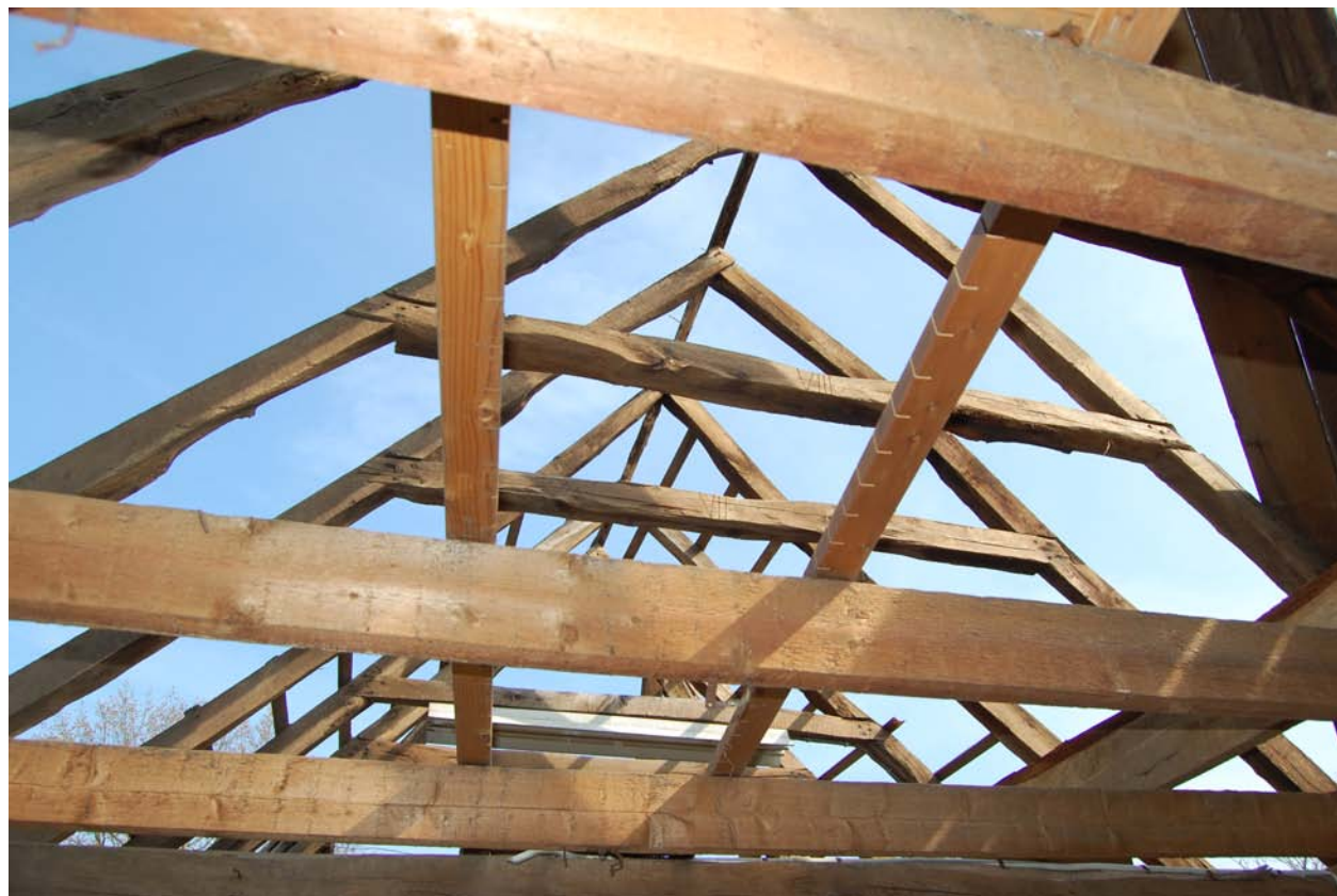
Kapconstructie opgebouwd uit eiken daksporen.
