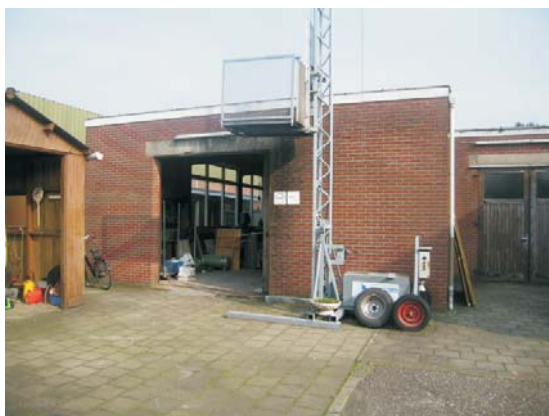
Opden deur werkplaats
