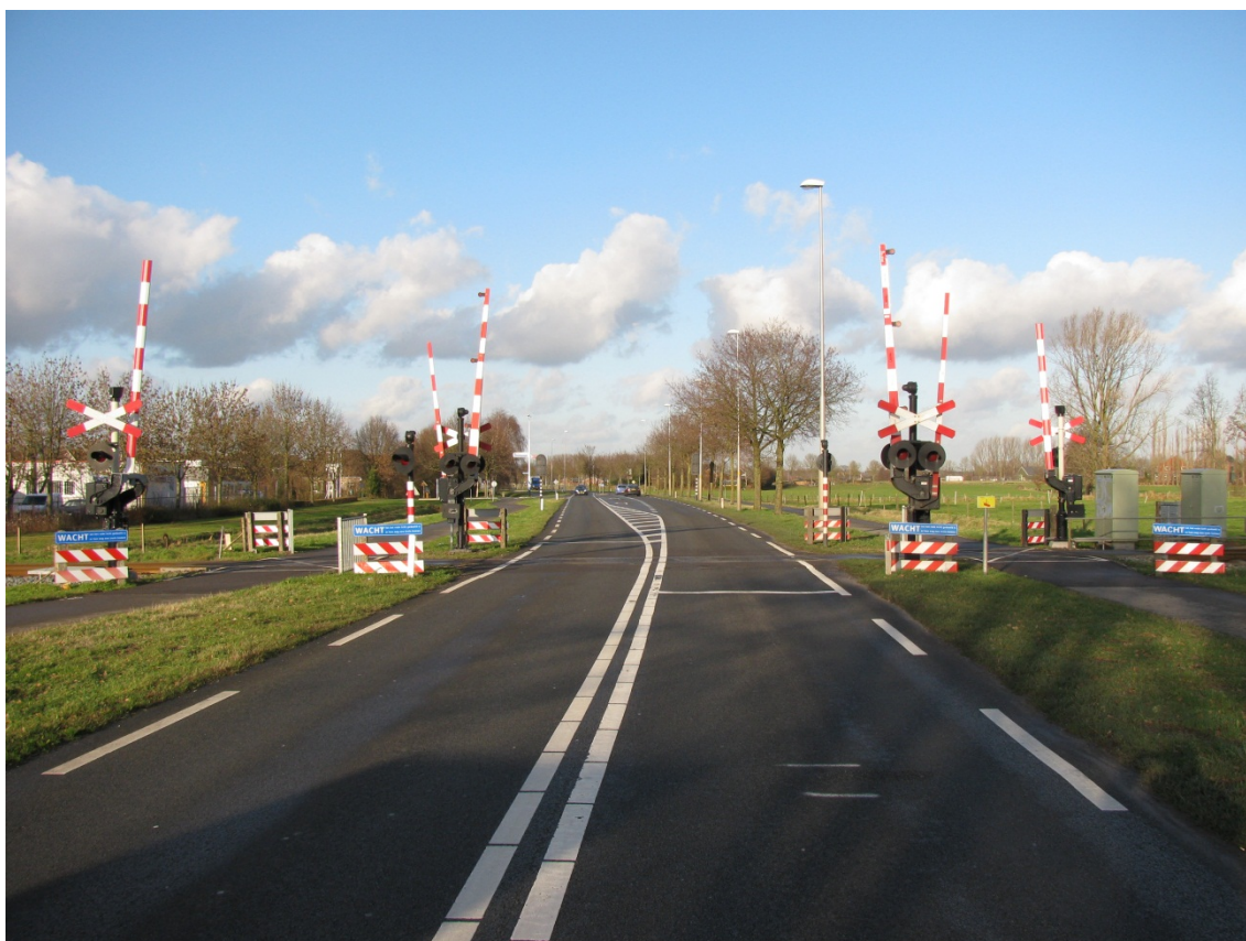
Foto 1 – Weemstraat te Wehl, zuidzijde van de overweg
