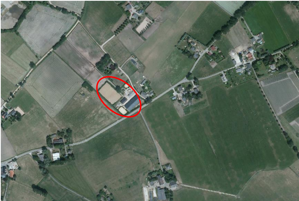
Afbeelding 1. Luchtfoto ligging locatie.
