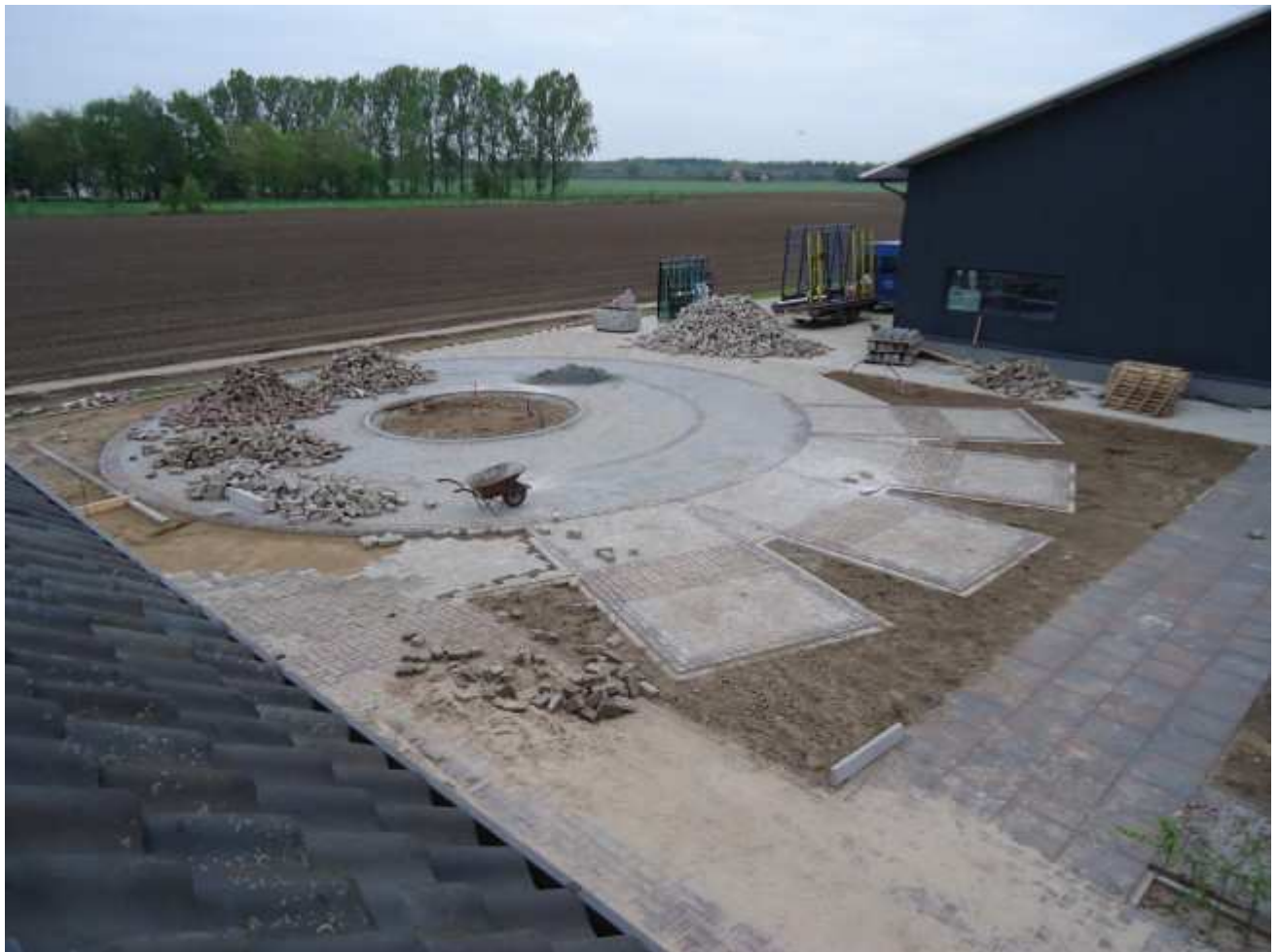
Grond- en straatwerk is een belangrijke activiteit van Hofstad.
