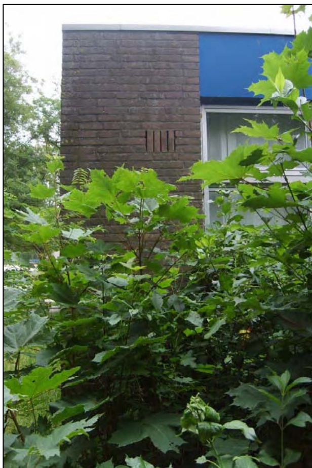
Mogelijke toegangsoeningen tot geschikte schuilplaatsen voor vlemuizen. Linkerzijde: spouwmuren met open stootvoegen of ventilatievoegen. Rechts: kieren die mogelijk toegang bieden tot spouwruimtes.
