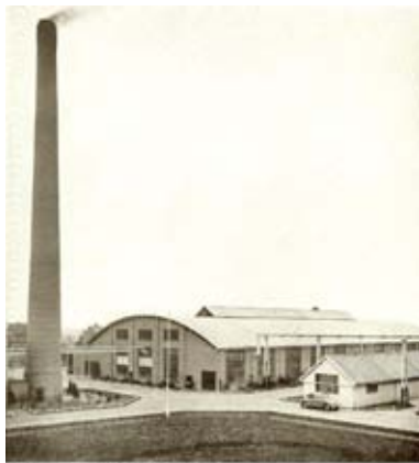
Buizen- en condensatorfabriek van de Industrie Philips te Doetinchem. Architect: Philip Broekman
