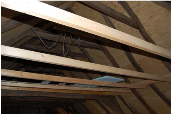
Herstelde eiken daksporen van de kap van het woongedeelte.
