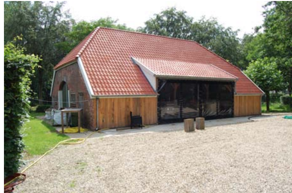
De zijgevel van de doorrijschuur is vernieuwd en voorzien van grote openingen.
