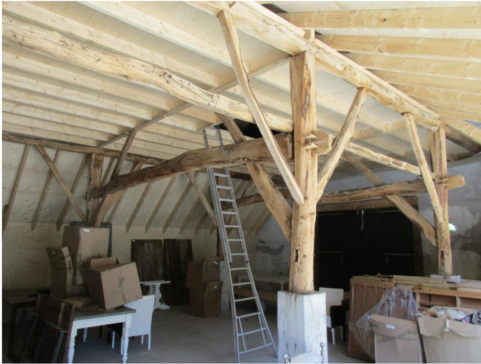
Overzichtsfoto's van de ankerbalkgebintconstructie van de vrijstaande schuur.
