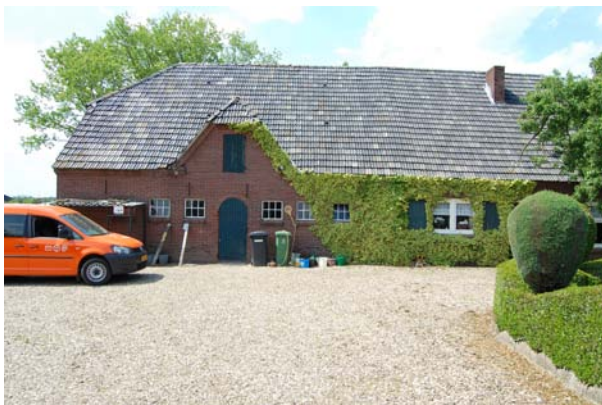
Linker zijgevel. Het dak is gedekt met gesmoorde muldenpannen en rondom is geen goot aangebracht.
