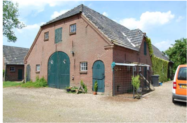
Traditioneel ingedeelde achtergevel met dubbele deeldeuren, staldeuren en een hooiluik. In de zijgevel is in een verhoogd deel een tweede hooiluik aangebracht.
