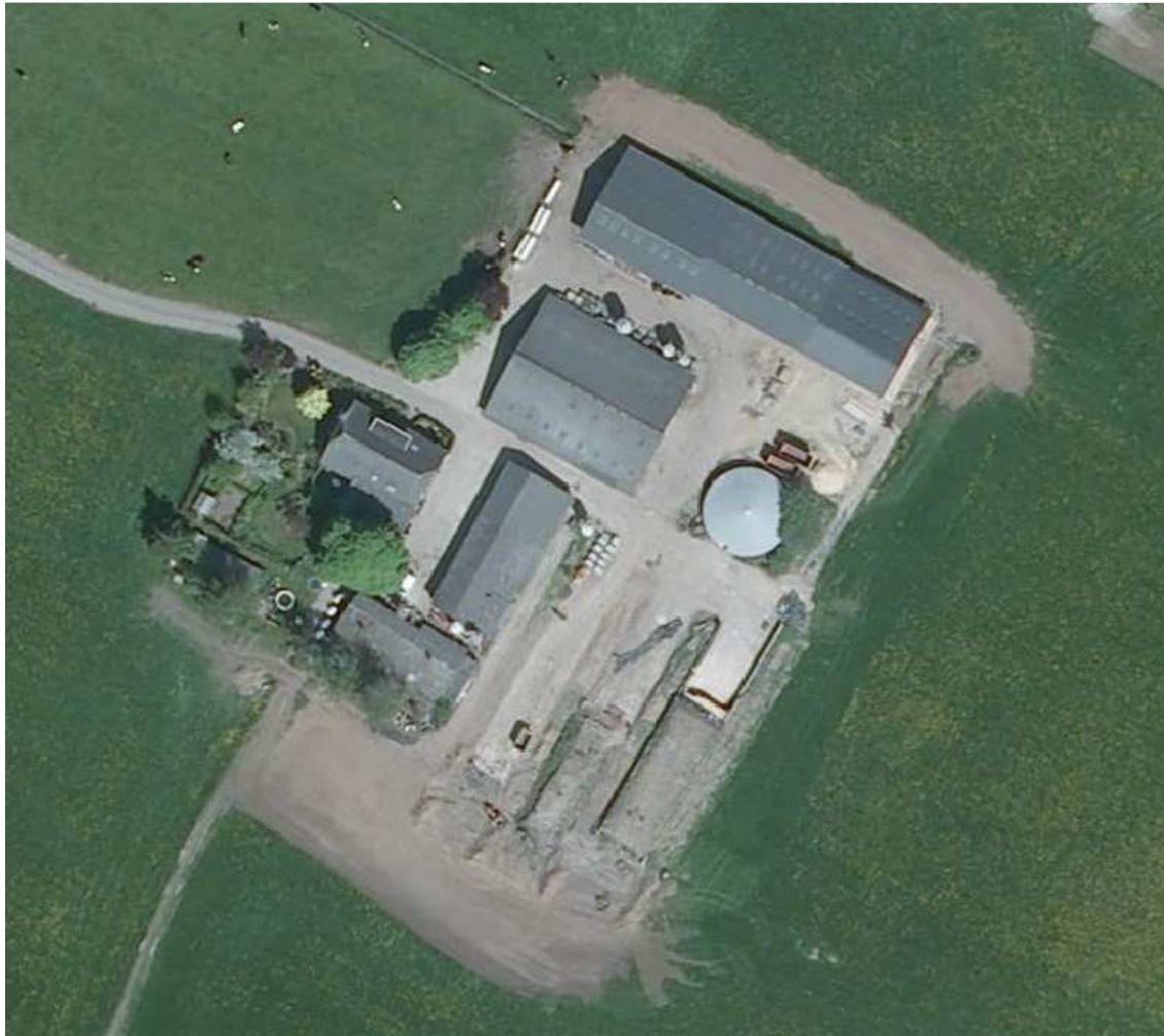
Luchtfoto van het erf. Deze foto is genomen van de oude situatie; dus voor uitbreiding van de loopstal (bron: provincie Gelderland).
