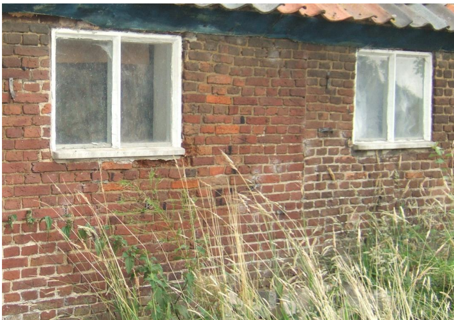
Detail van de linker zijgevel. Duidelijk zichtbaar is de bouwnaad in het metselwerk.
