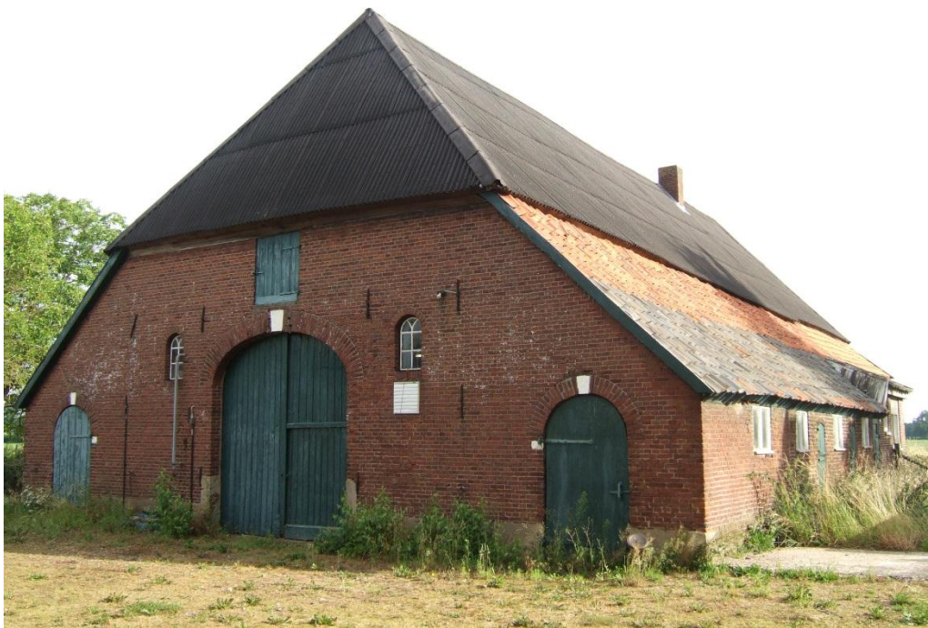
Achtergevel en deel van de linker zijgevel.
