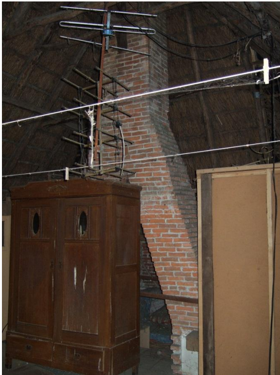
Het schoorsteenkanaal in het voorhuis.
