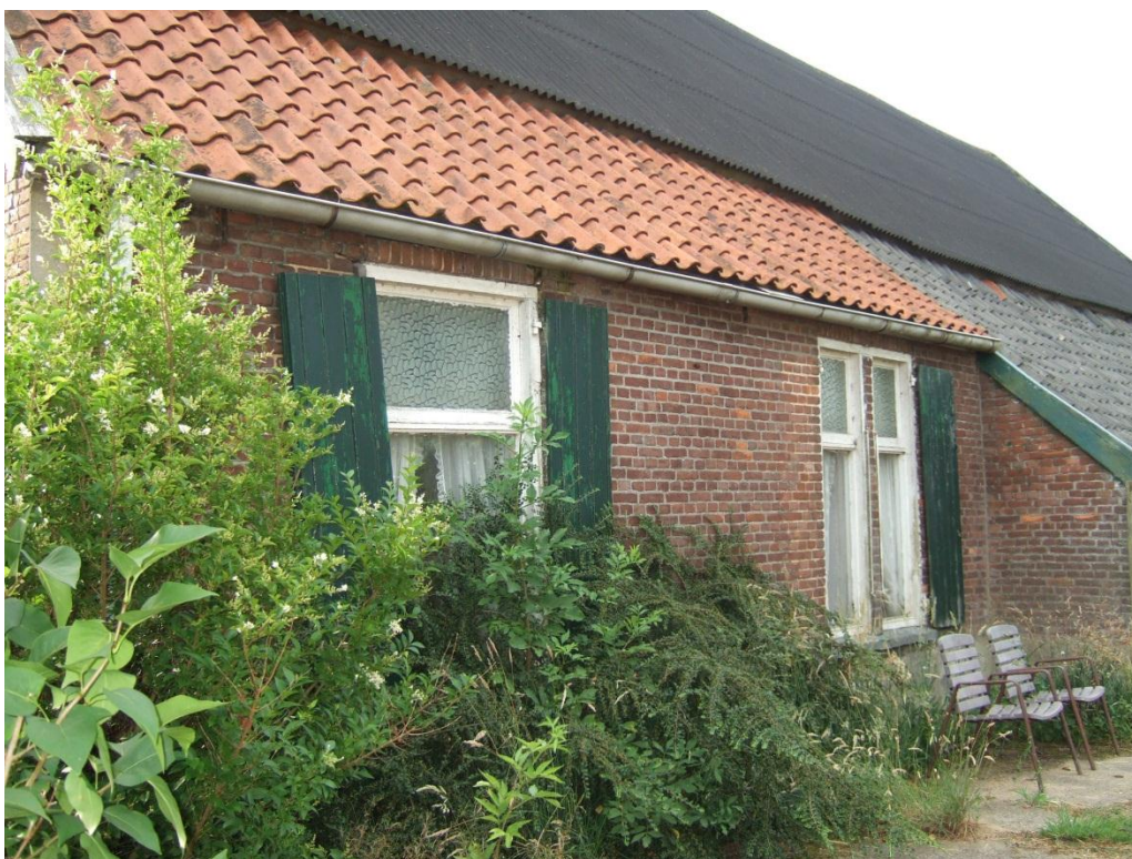
Rechter zijgevel ter plaatse van het voorhuis.
