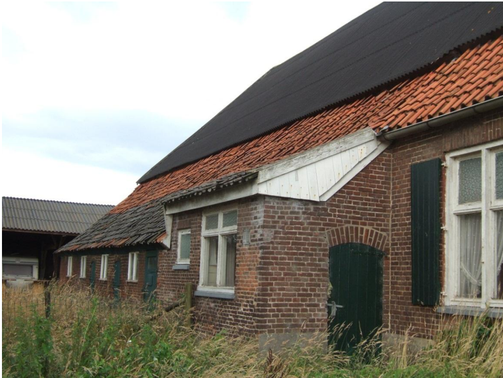
Linker zijgevel ter plaatse van het achterhuis.
