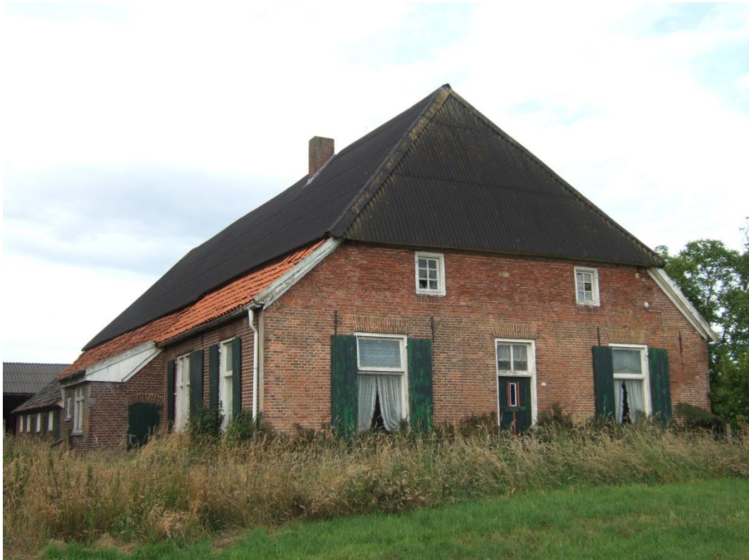
Voorgevel en linker zijgevel van de boerderij.
