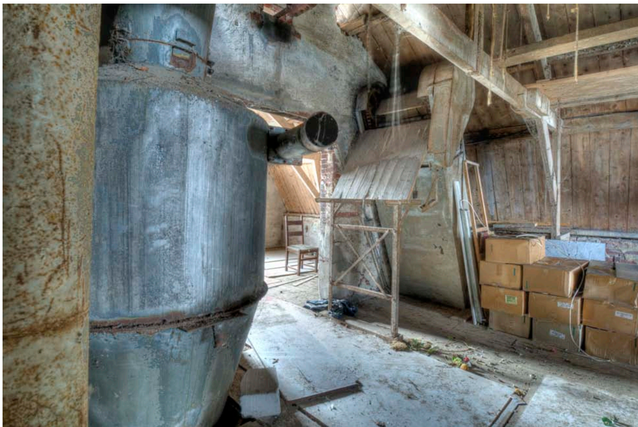
Op het oostelijke deel van de zolder van het maalderijgebouw staan aan de voorzijde een transportband en tegen de achtergevel een zogenaamde cycloon.
