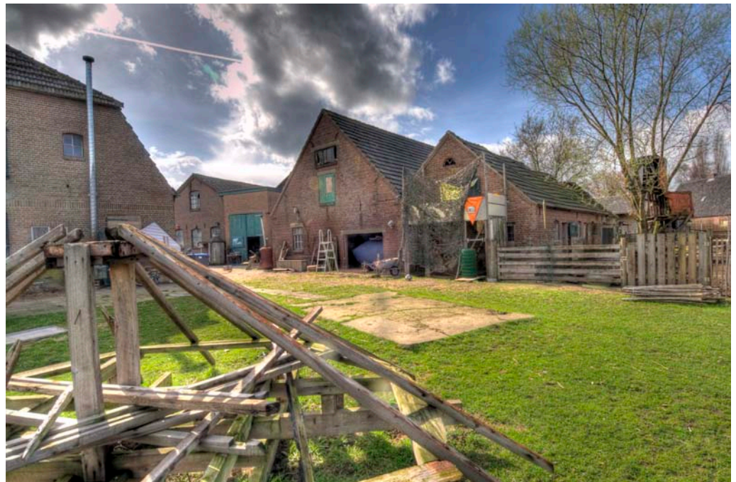
Overzicht van de beide maalderijgebouwen vanaf de achterzijde van het erf.
