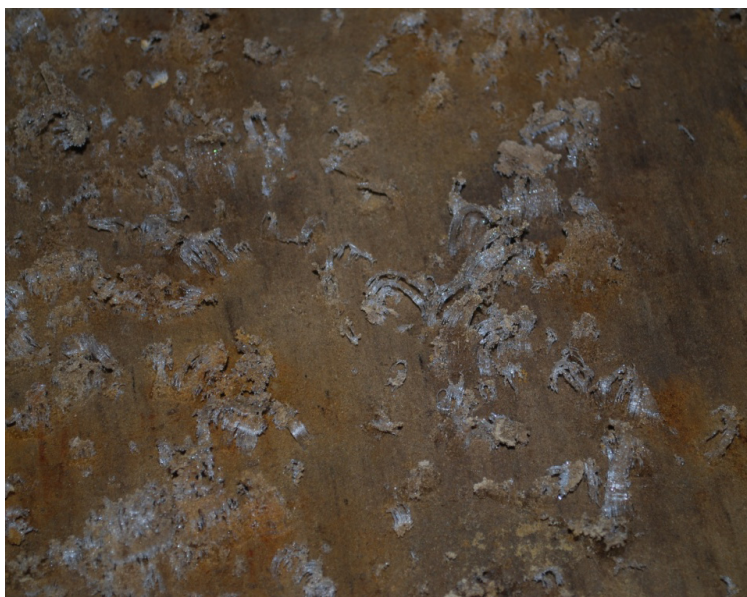
Afb. 4. Na een weekend met strenge vorst was het vlak gedeeltelijk opgetild door de gevormde ijskristallen in het vlak.
