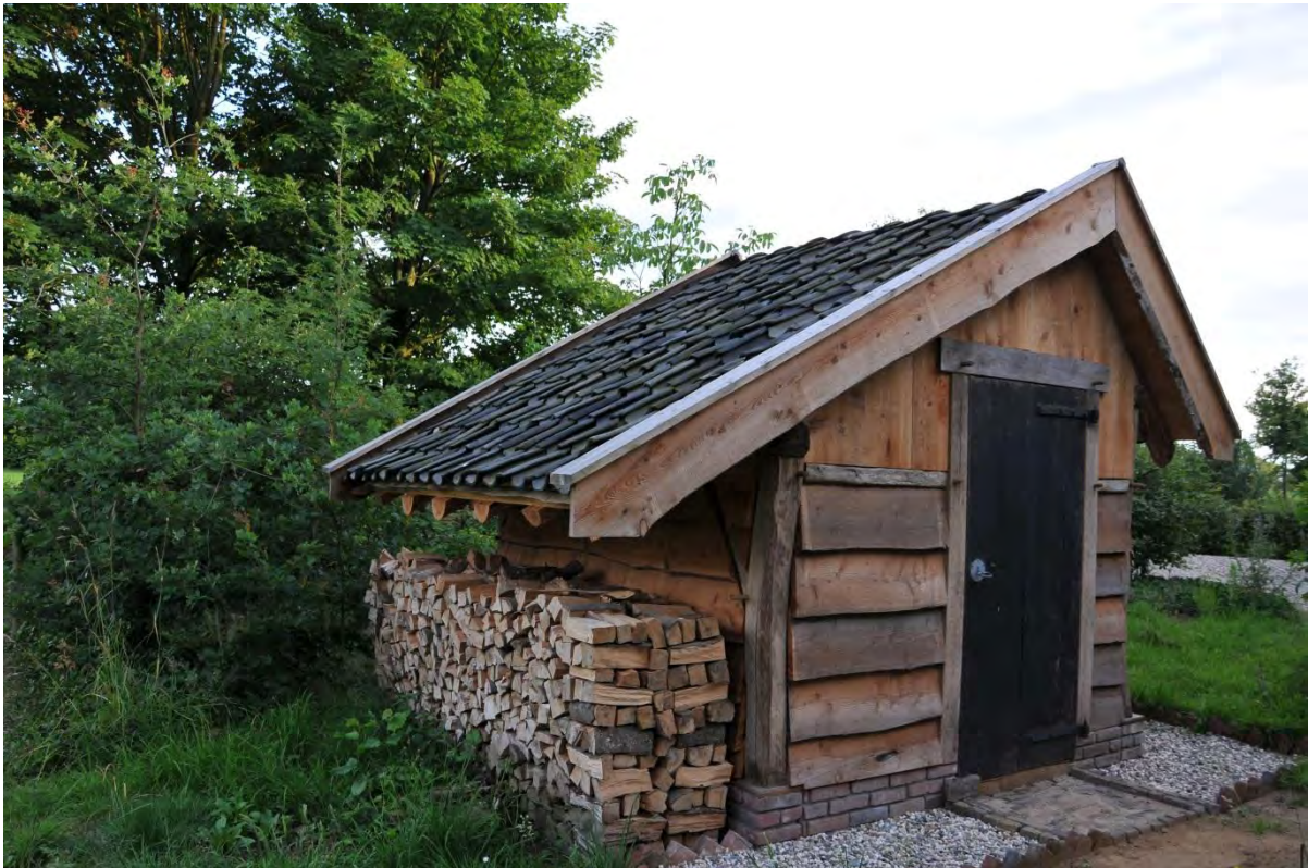
Afb. 2. Voorbeeld potdekselwerk
