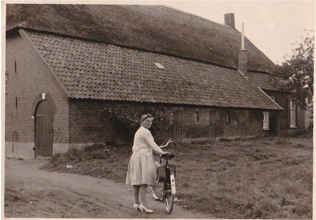
Historische foto met zicht op de linker zijgevel (collectie eigenaar).
