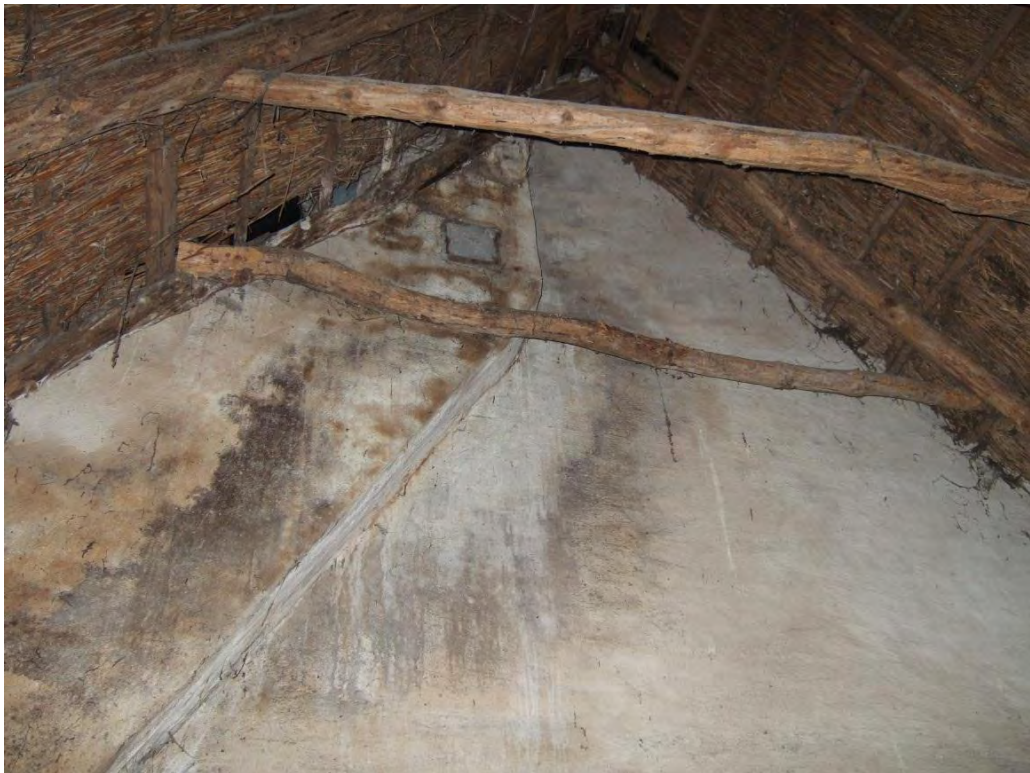
De brandmuur is tot in de nok opgemetseld.
