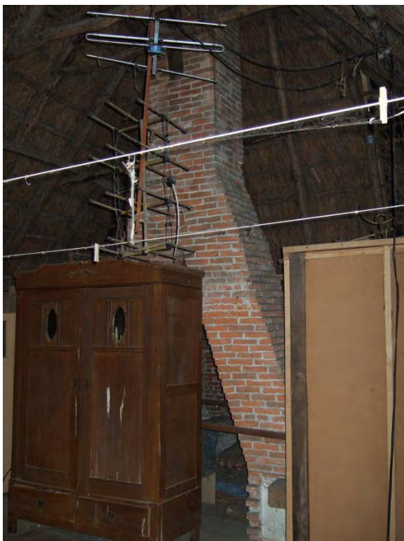
Het schoorsteenkanaal in het voorhuis.
