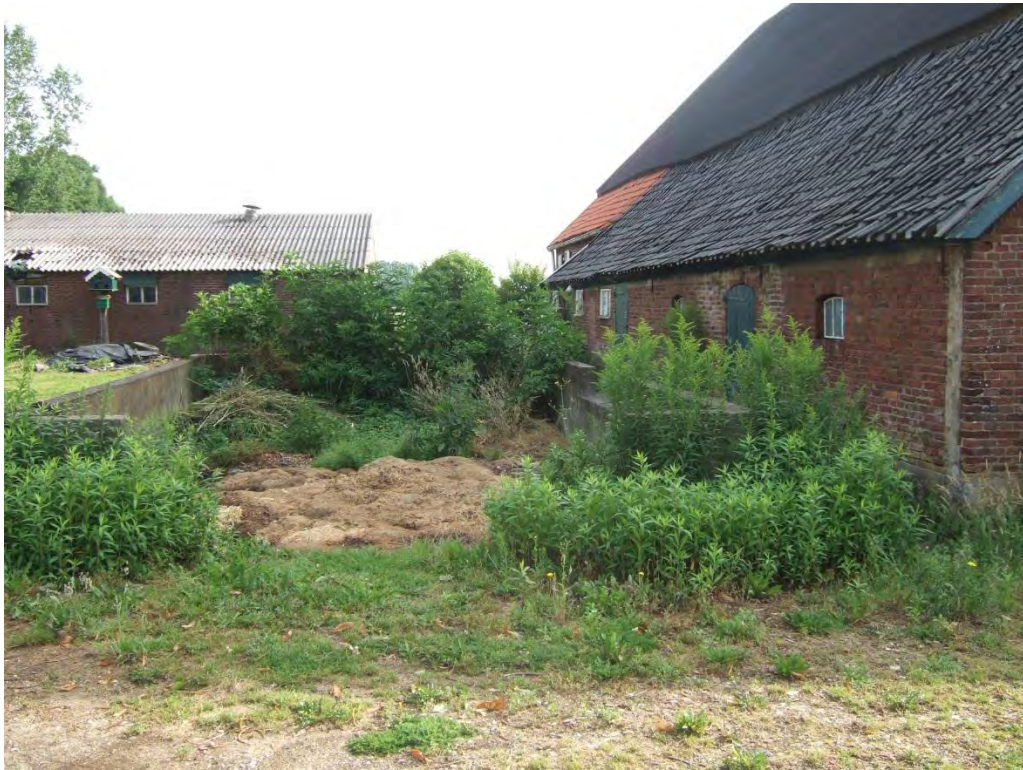
De mestplaats bevindt zich voor de rechter zijgevel van de boerderij.
