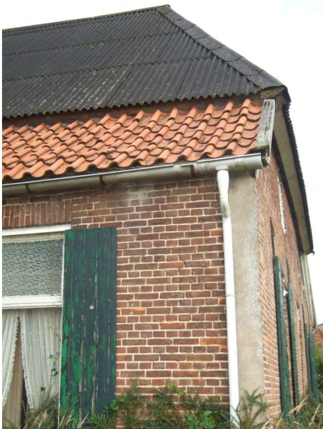
De hoek van de linker zijgevel is voorzien van een gepleisterde band. Waarschijnlijk bedoeld om de bouwsporen weg te werken.
