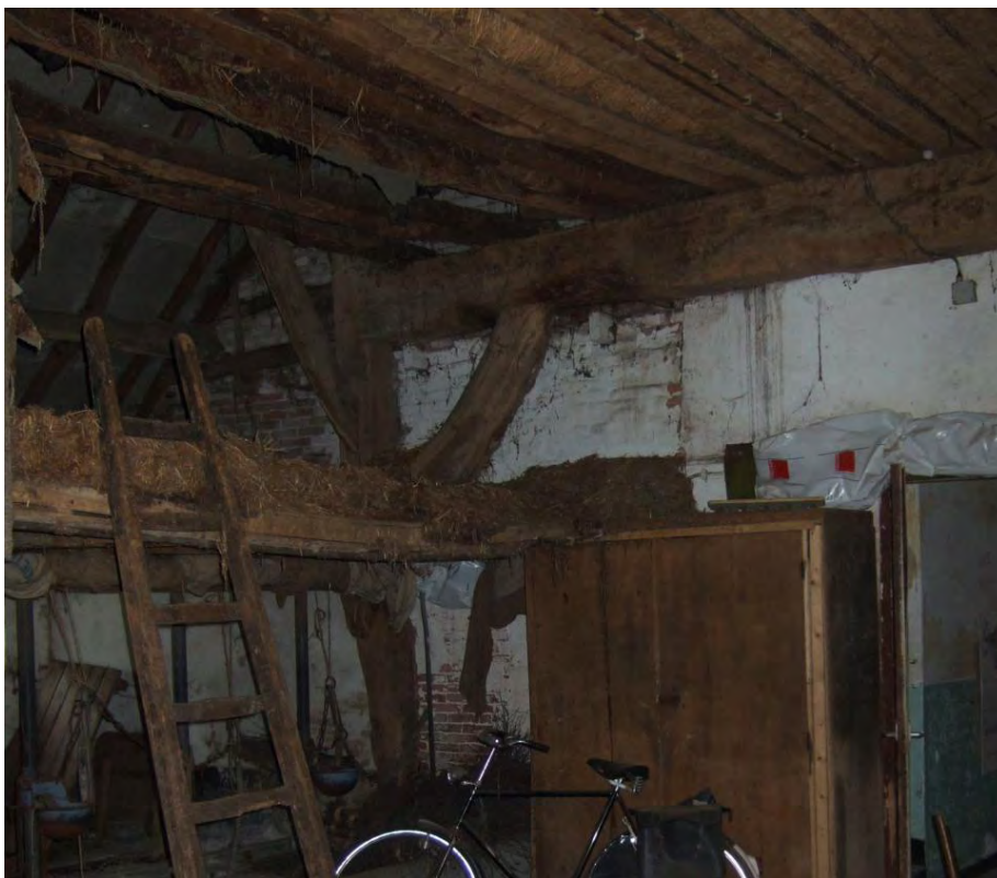
De gebintconstructie in het achterhuis staat tegen de brandmuur.
