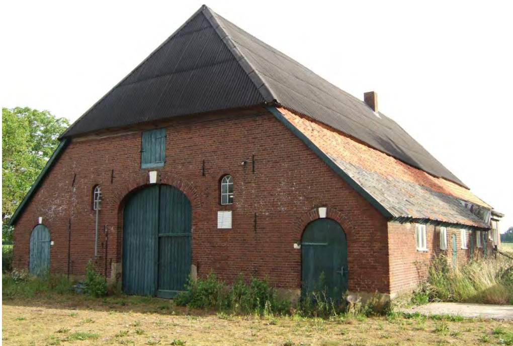
Achtergevel en deel van de linker zijgevel.
