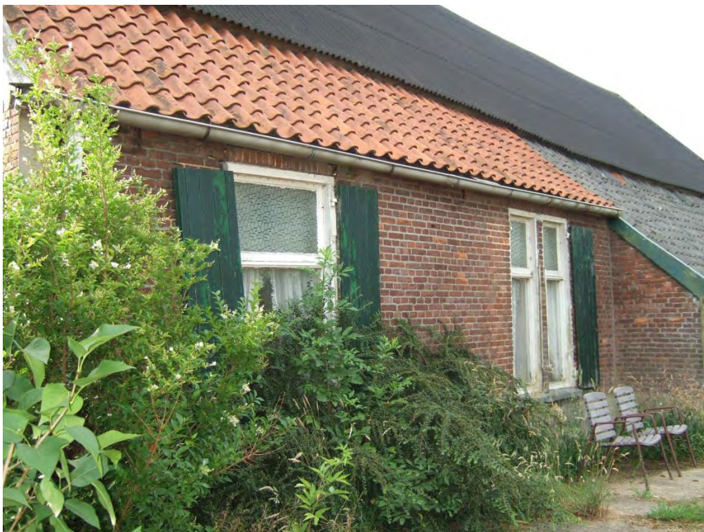
Rechter zijgevel ter plaatse van het voorhuis.
