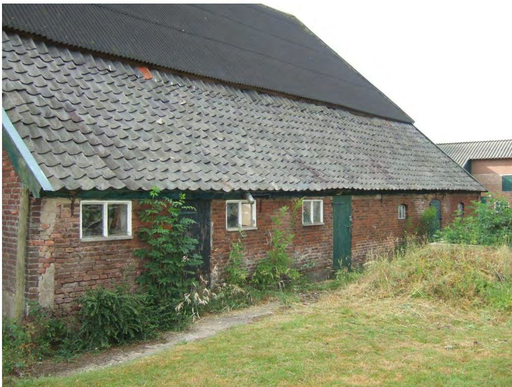
Rechter zijgevel ter plaatse van het achterhuis.
