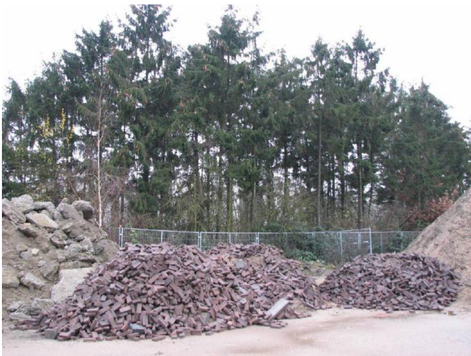
Foto 5: Tijdelijke opslag van klinkers, grond en gebroken puin.
