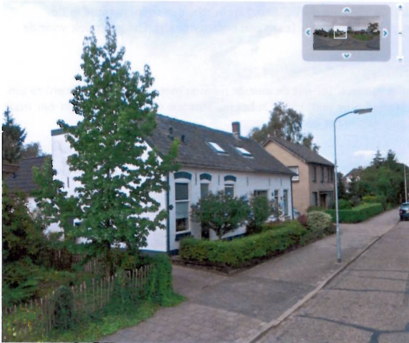
Bebouwing langs de zuidzijde van de Tollensstraat (bron: Google Earth streetview)
