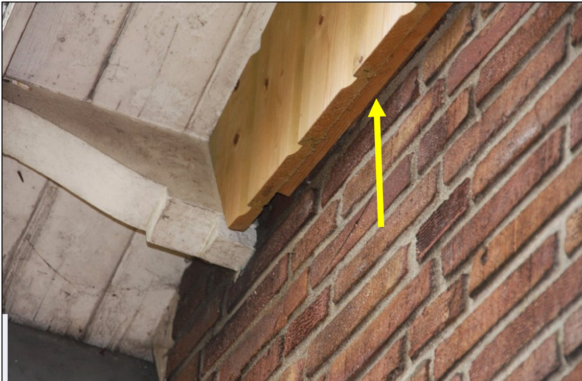
Figuur 5. Voorbeeld van ruimtes achter betimmeringen waar vleermuizen kunnen verblijven (Bron www.checklistgroenbouwen.nl ).
