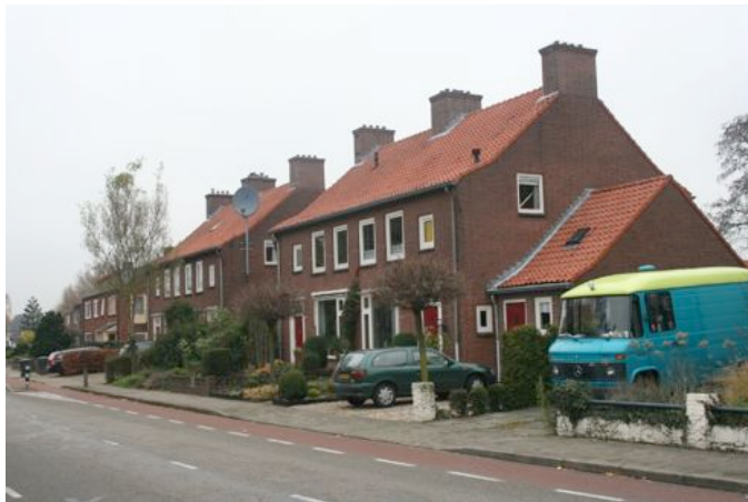
Afb. 12. Blokjes woningen aan de Frans Halsweg uit de Wederopbouw-periode.
