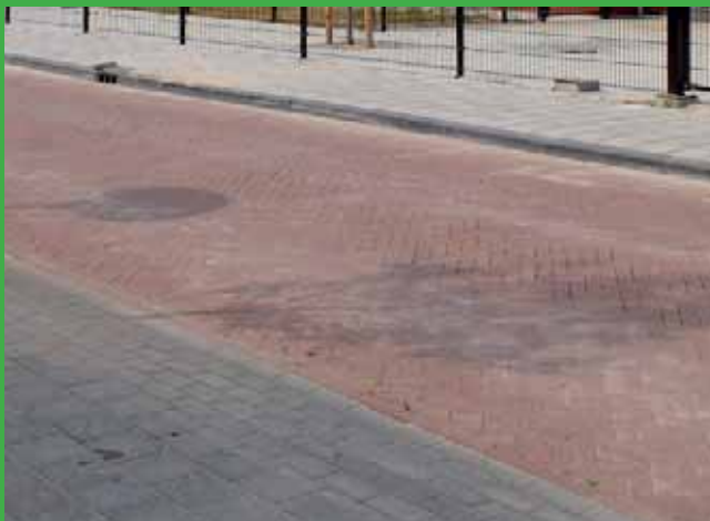
Rijbaan in BSS mangaan, parkeerplaatsen in BSS basalt
