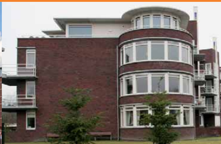
Kenmerkende detailleringen als een dakoverstek en erkers
