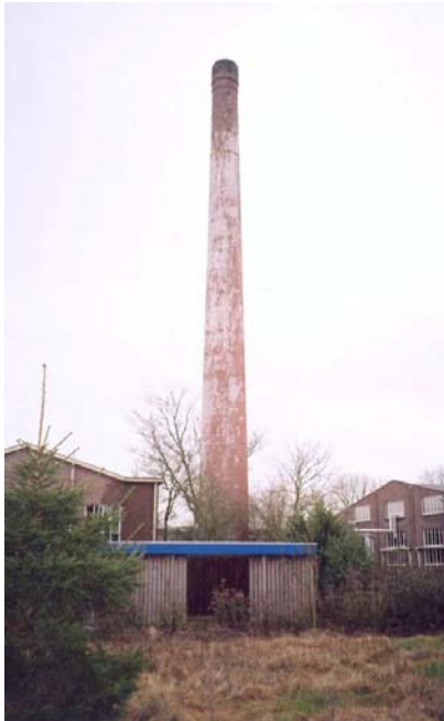
Rijwielbergplaats, met op de achtergrond het ketelhuis, de schoorsteen en gebouw A.
