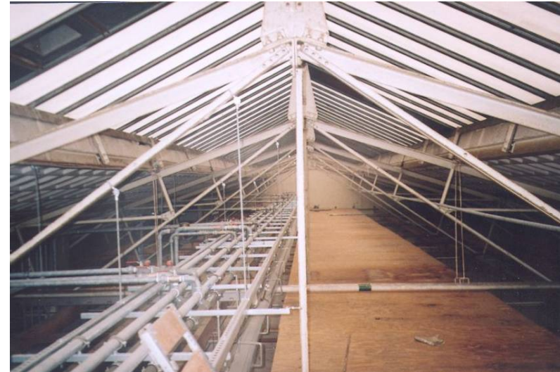
Dakconstructie, gebouw D.
