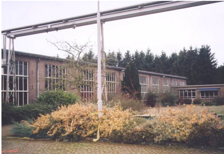
Rechter zijgevel, gebouw A / Deel voorgevel, verbindinggang tussen gebouw A en D.
