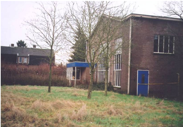
Grasveld met enkele bomen en struiken op de plaats van de voormalige entree naast het ketelhuis.
