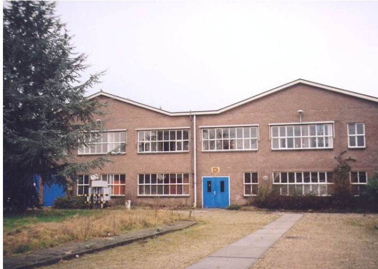
Voorgevel, gebouw D.
