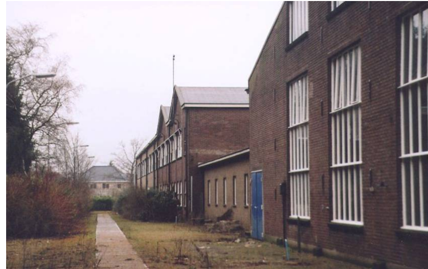
Achtergevels, gebouw A, D en F / Achtergevel verbindingsgang tussen gebouw A en D.
