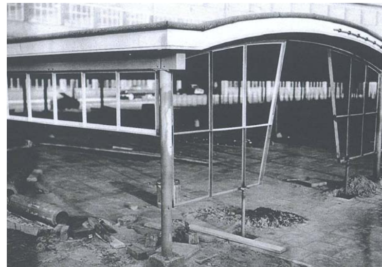
Bouw van de rijwielbergplaats met overkapping, 1955.
