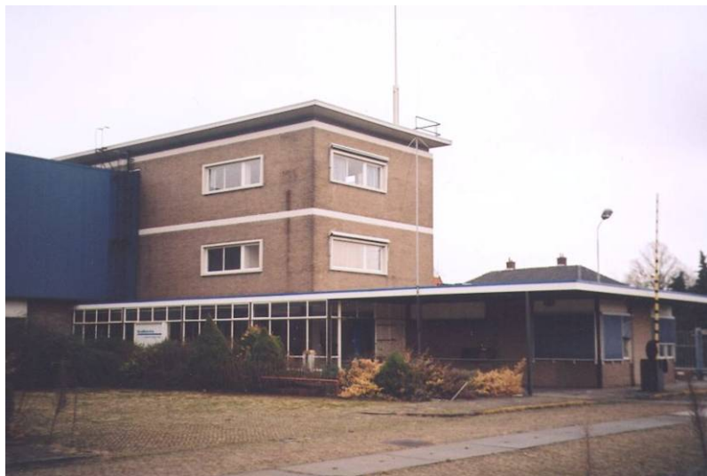
Gedeelte van de achtergevel, gebouw G.
