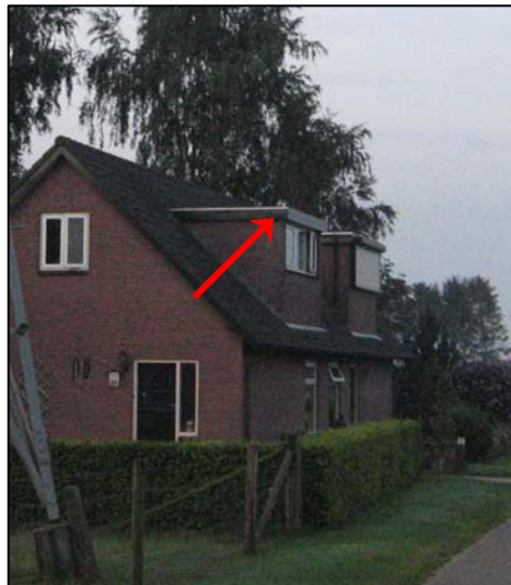
Foto 1: Locatie (rode pijl) van de paarverblijfplaats van een mannetje Gewone Dwergvleermuis. 'Onder de rand van de dakkapel'.
