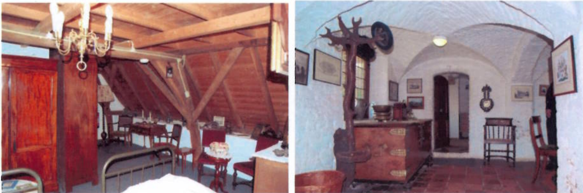
Overzicht van het interieur van de kelder en een gedeelte van de kapconstructie.
