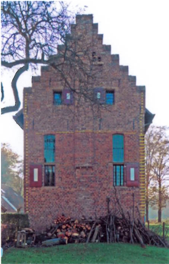
Noord- en zuidgevel met geel gemarkeerd de horizontale bouwnaad en de in de hoekoplossingen toegepaste strekken en klezoren.
