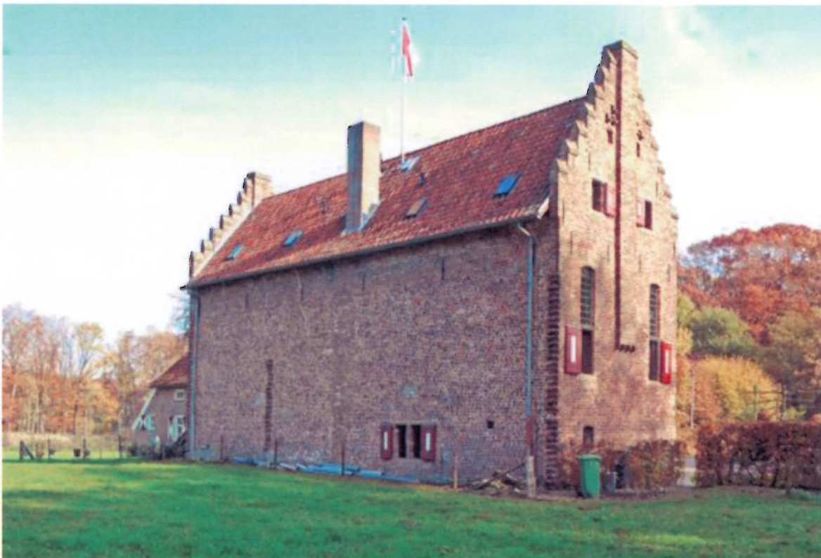
Het onderzochte huis, gezien vanaf het zuidwesten.
