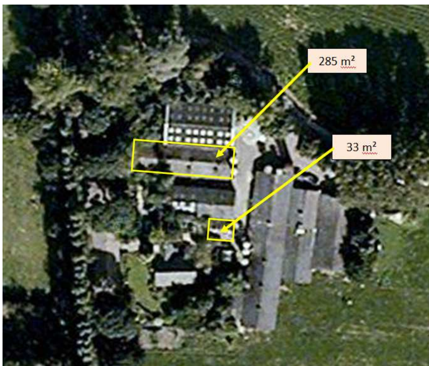
Figuur 2.5: overzicht te slopen bebouwing Bredestraat 4
