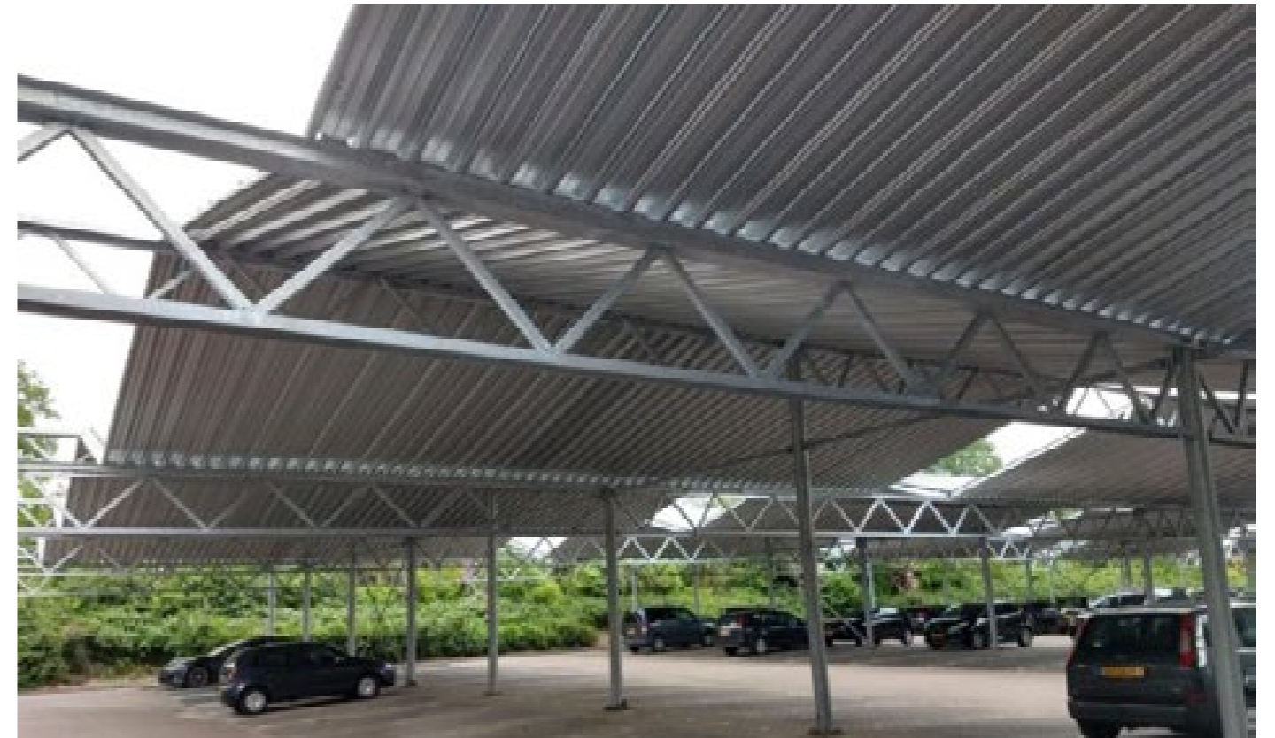
het dak van zonnepanelen is ook een gezamenlijke carport voor de buurt
