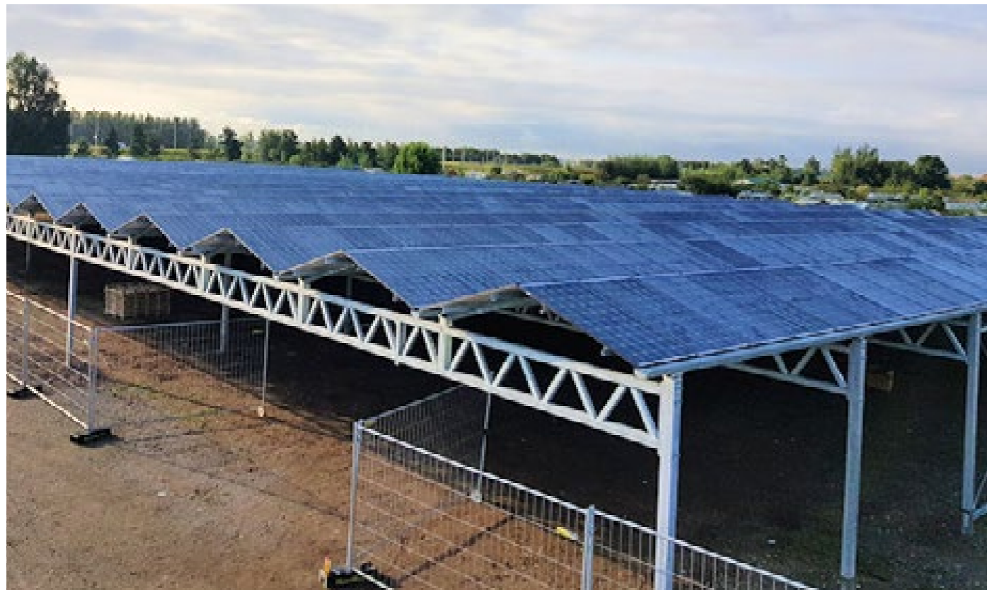
constructie uit de kassenbouw als onderbouw voor het dak met zonnepanelen
