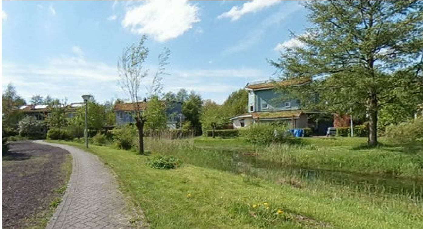
Van een afstand zijn de groendaken goed zichtbaar
