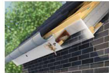
nestkasten in dakconstructie
