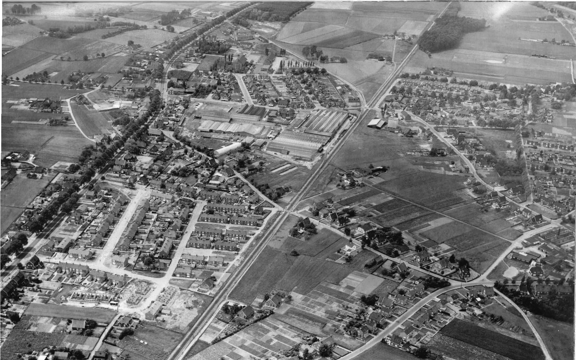
Luchtfoto van Gaanderen uit 1964 met in het midden de spoorlijn en links het tracé van de Rijksweg (het noorden is rechts). Links van de spoorweg is de Vogelbuurt verrezen, daarboven ligt nog altijd het na 2004 verdwenen fabrieksterrein van Pelgrim/Neerlandia. Ten noorden van de spoorweg bestaan tussen de lintbebouwing nog grote open terreinen die in loop van de 20e eeuw deels bebouwd zouden worden.
