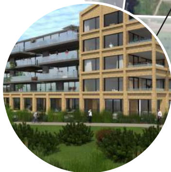
Bouwblok 'Havenkwartier' in aanbouw
