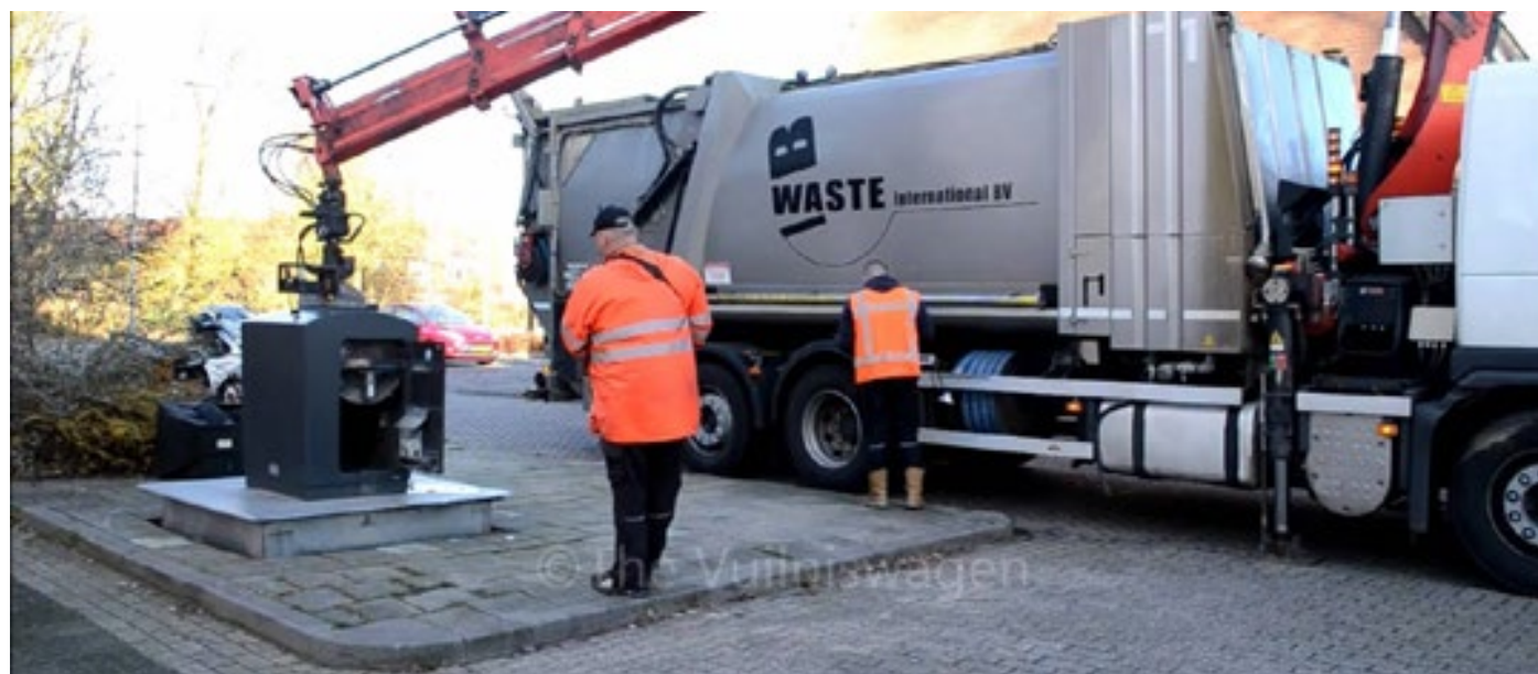
leggen ondergrondse containers
