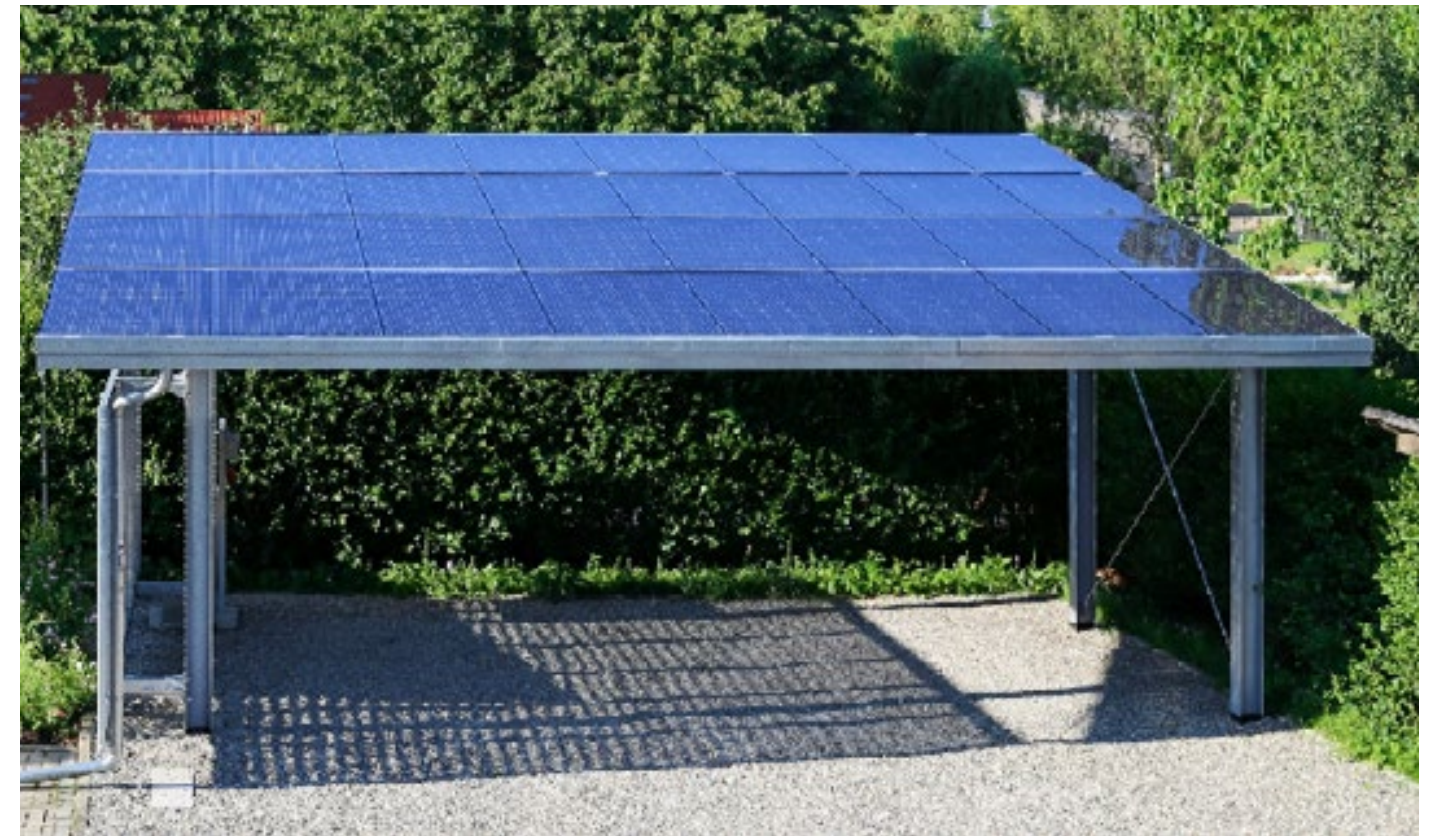
carport met zonnepanelen als dak, glazen panelen zorgen voor licht onder de carport
