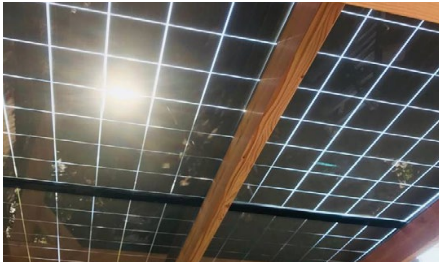
transparante dakconstructie van zonnepanelen
