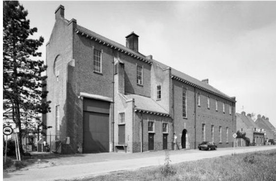
Het in 1935 gebouwde en omstreeks 1950 uitgebreide onderstation van de PGEM op de kruising van de Keppelseweg en de Energieweg.
