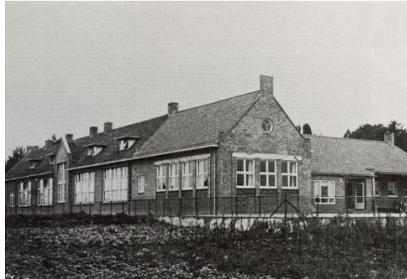
De eerste lokalen van de meisjesschool, gelegen achter het zustershuis werden gebouwd in 1932. De school werd tweemaal uitgebreid met twee extra lokalen, in 1949 en in 1953.
