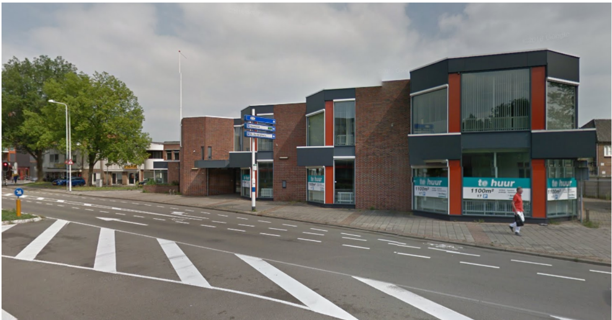
Het gebouw van de voormalige ING-Bank vanaf de Raadhuisstraat (bron: Google Streetview, augustus 2015)
