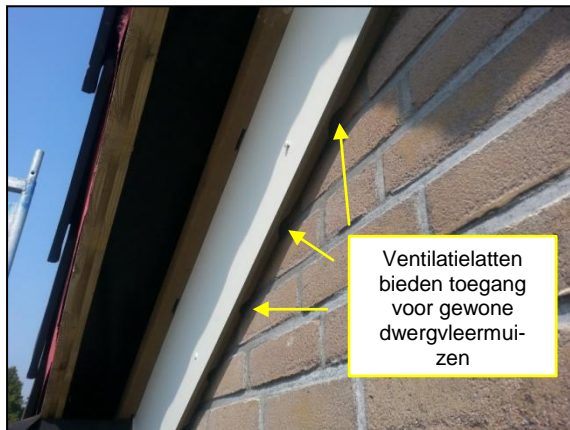
Figuur 17. Vlemuisvriendelijke afwerking dakrand.
