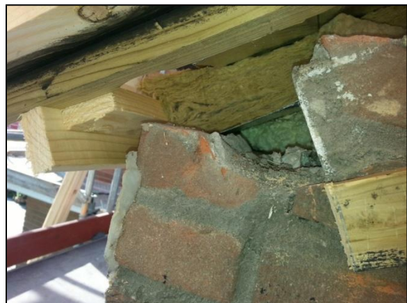
Figuur 21. De bevestigingslat van de dakrand wordt afgekort ter hoogte van de nis.
