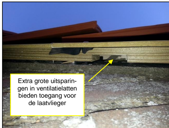
Figuur 18. Vlemuisvriendelijke afwerking dakrand
