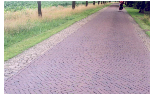
weg met klinkers en keien
