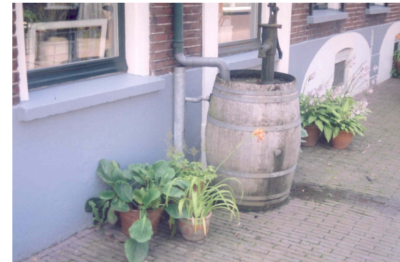
infiltratie van regenwater
