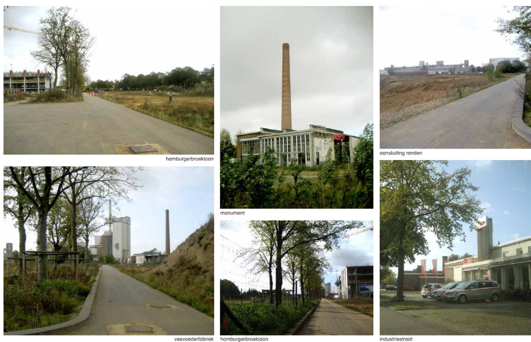
Figuur 2: Foto's situatie voorafgaand aan sloop fabriek
