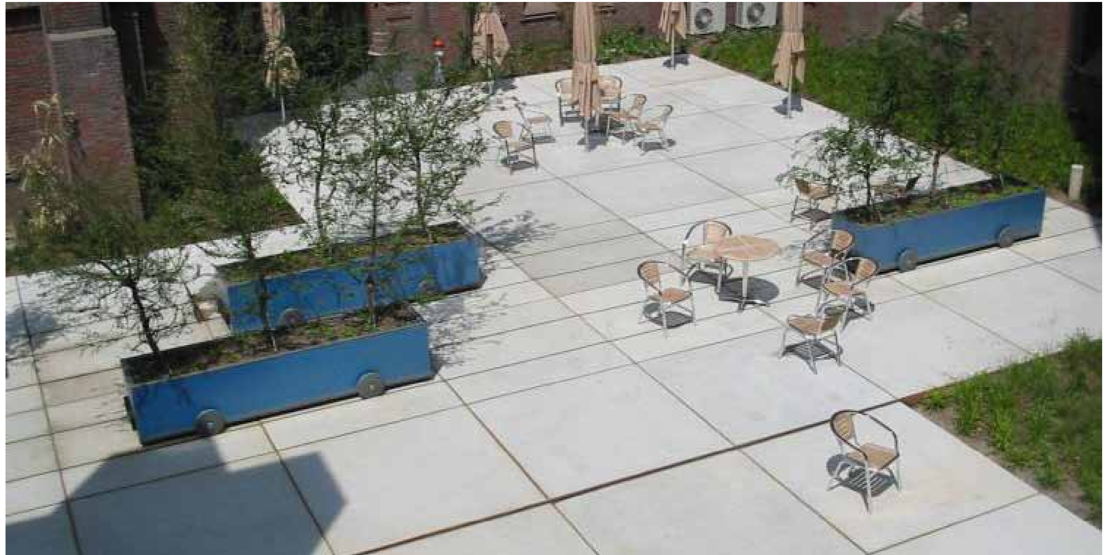
Verhardingsmateriaal binnenplaats bij ketelhuis
