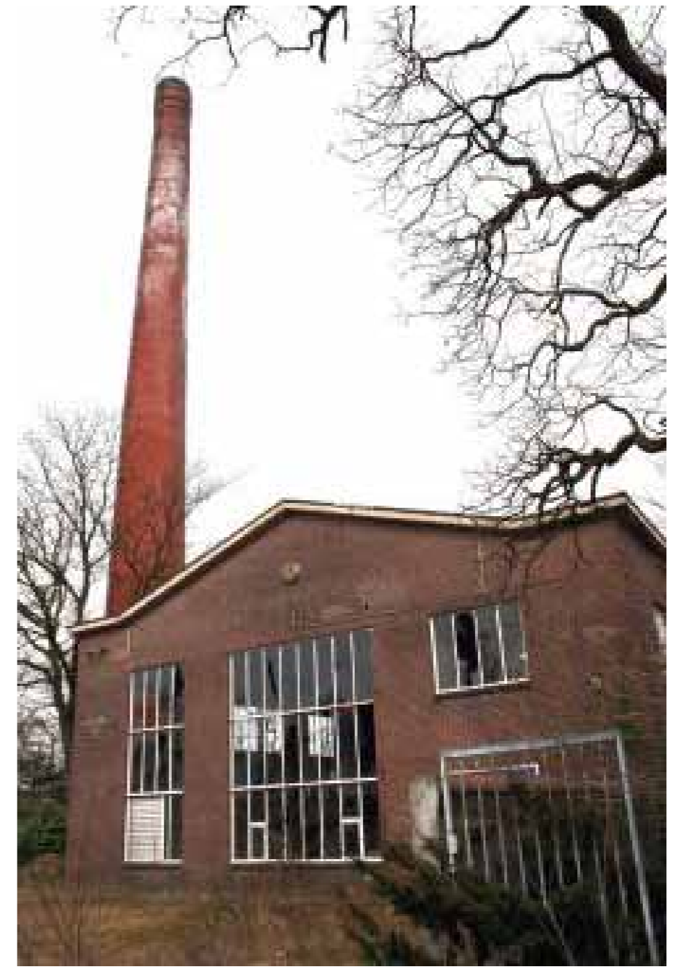
Ketelhuis te restaureren
