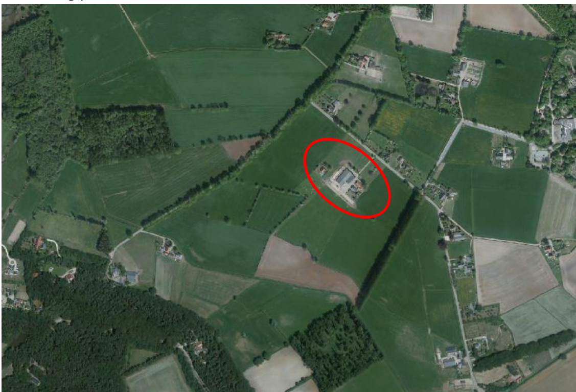
Afbeelding 1. Luchtfoto ligging locatie.
