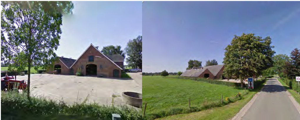
Aanzicht op het erf vanuit de zuidzijde (bron: Google).
