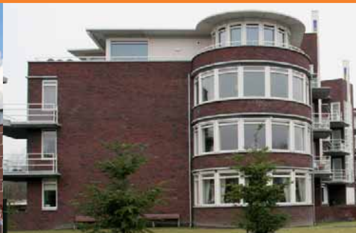
Kenmerkende detailleringen als een dakoverstek en erkers
