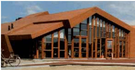
Lage goot en flauwe dakhelling
