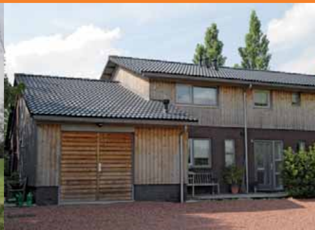
Naar voren stekende uitbouw bij rijwoning
