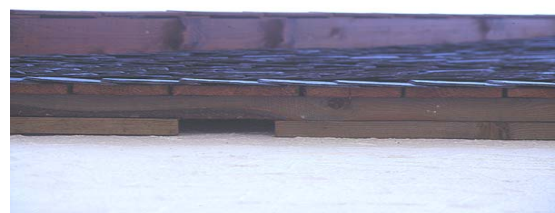
Foto 1: Gecreëerde open ruimte achter gevelbetimmering; onderaanzicht
