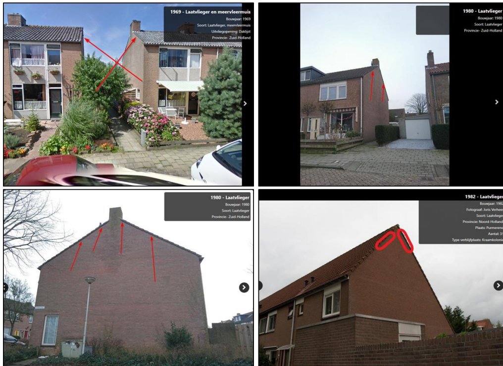
Figuur 4 Aangetroffen vaste rust- en verblijfplaatsen. Van veraf lijken er zelfs geen openingen aanwezig te zijn. De kantpannen dienen als, eis voor een vleermuis verblijfplaats, aan te sluiten op de kopgevel (bron: www.gebouwbewonend.nl )
