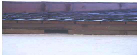
Foto 1: Gecreëerde open ruimte achter gevelbetimmering; onderaanzicht
