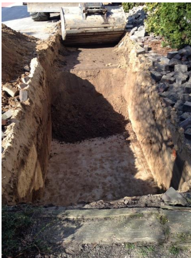
Afbeelding 4: wp 1 aanleg vlak
