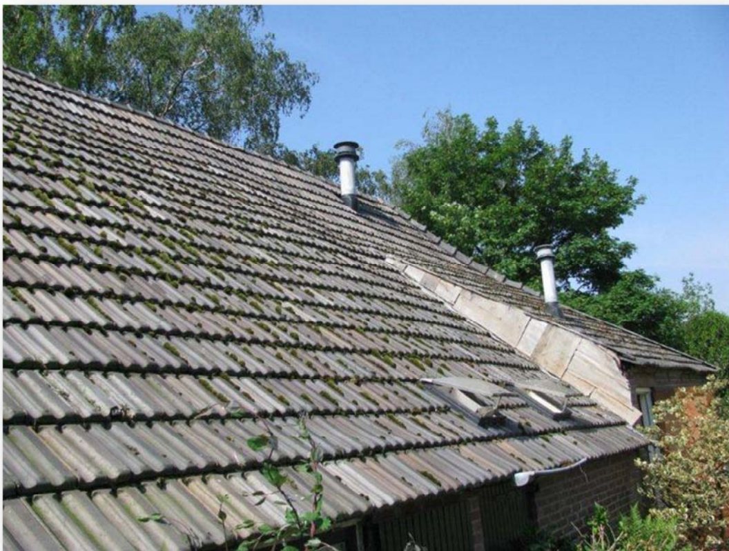
Zicht op de oostzijde van de kap van de boerderij (met eenzijdig sleepdak)
