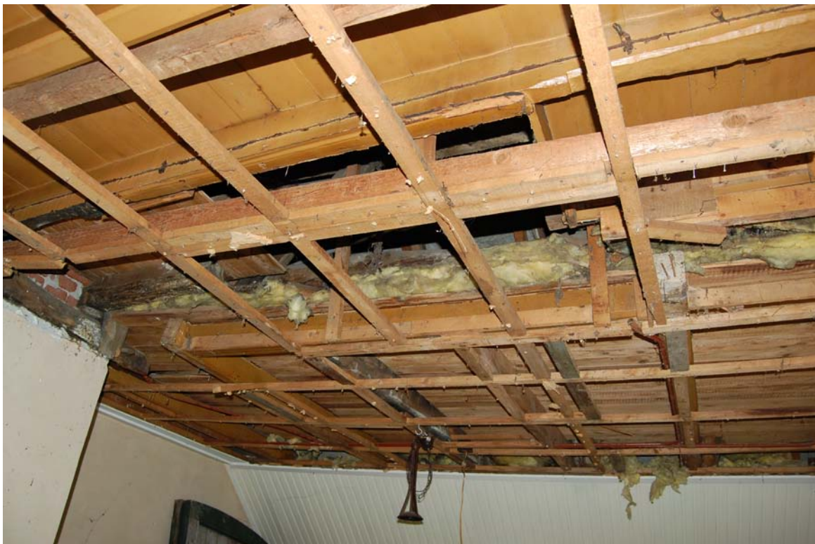
Enkelvoudige balklaag van het woongedeelte met daarin de forse raveling van de verdwenen schouw.
