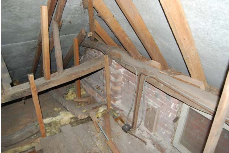
Binnenzijde van de voorgevel uit 1912, die met dezelfde bakstenen als de huidige achtergevel is opgetrokken.
