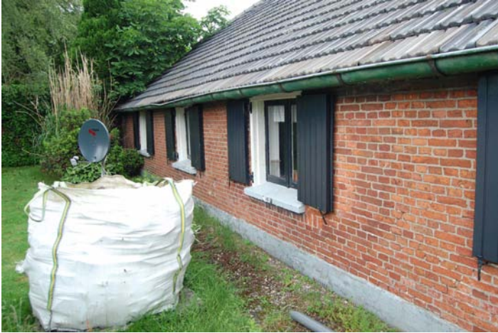
Voorste deel van de rechter zijgevel.
