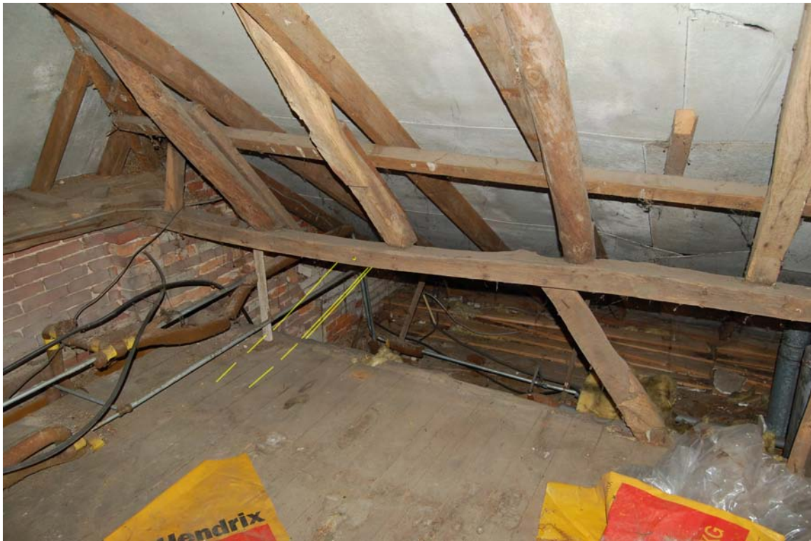
Gebintplaat aan de oostzijde achter de voorgevel. In geel is een verdwenen windschoor aangegeven die oorspronkelijk met de houten voorgevel verbonden geweest zal zijn.
