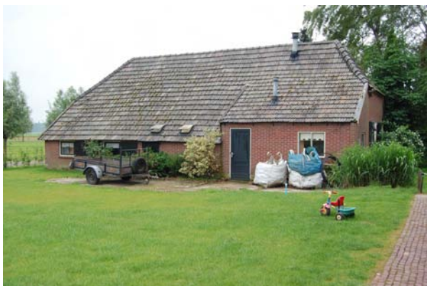
Linker zijgevel en voorgevel.
