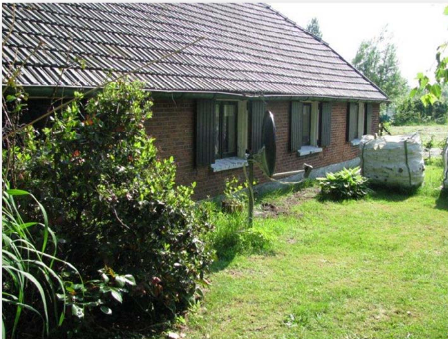
Bestaande westgevel, zicht op tuin met gazon en enkele sierheesters en grassen.
